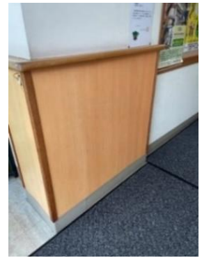
写真1 目立たない配色の手すり
