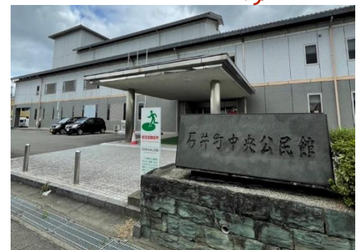
写真1 指定避難所となっている 中央公民館外観
