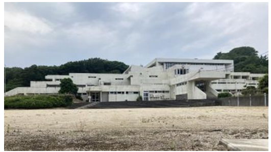
図-1 島田小学校・幼稚園外観
